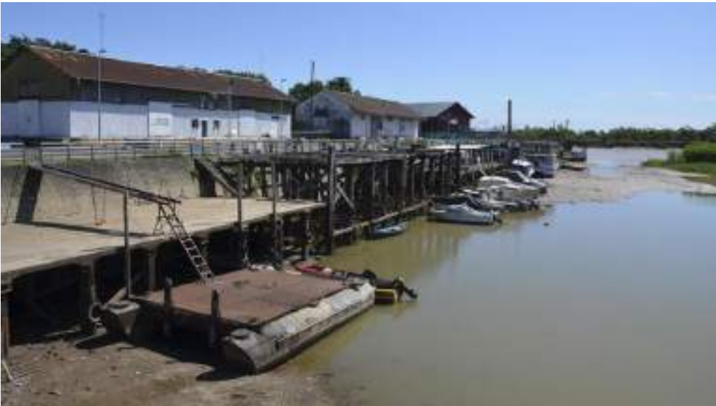
Imagen de la bajante del río Paraná en el puerto.
